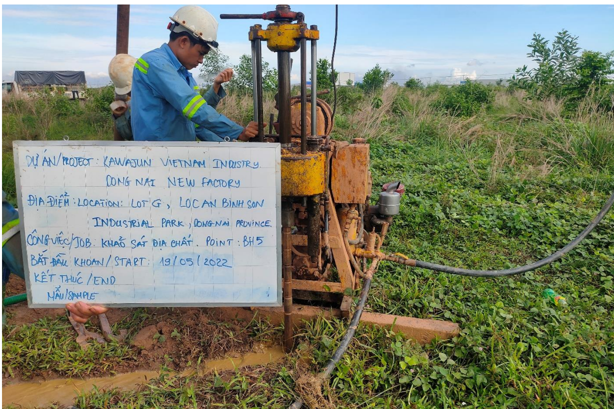
Hình 1: Công tác khoan trên cạn/ Fig.1: Drilling work on land
