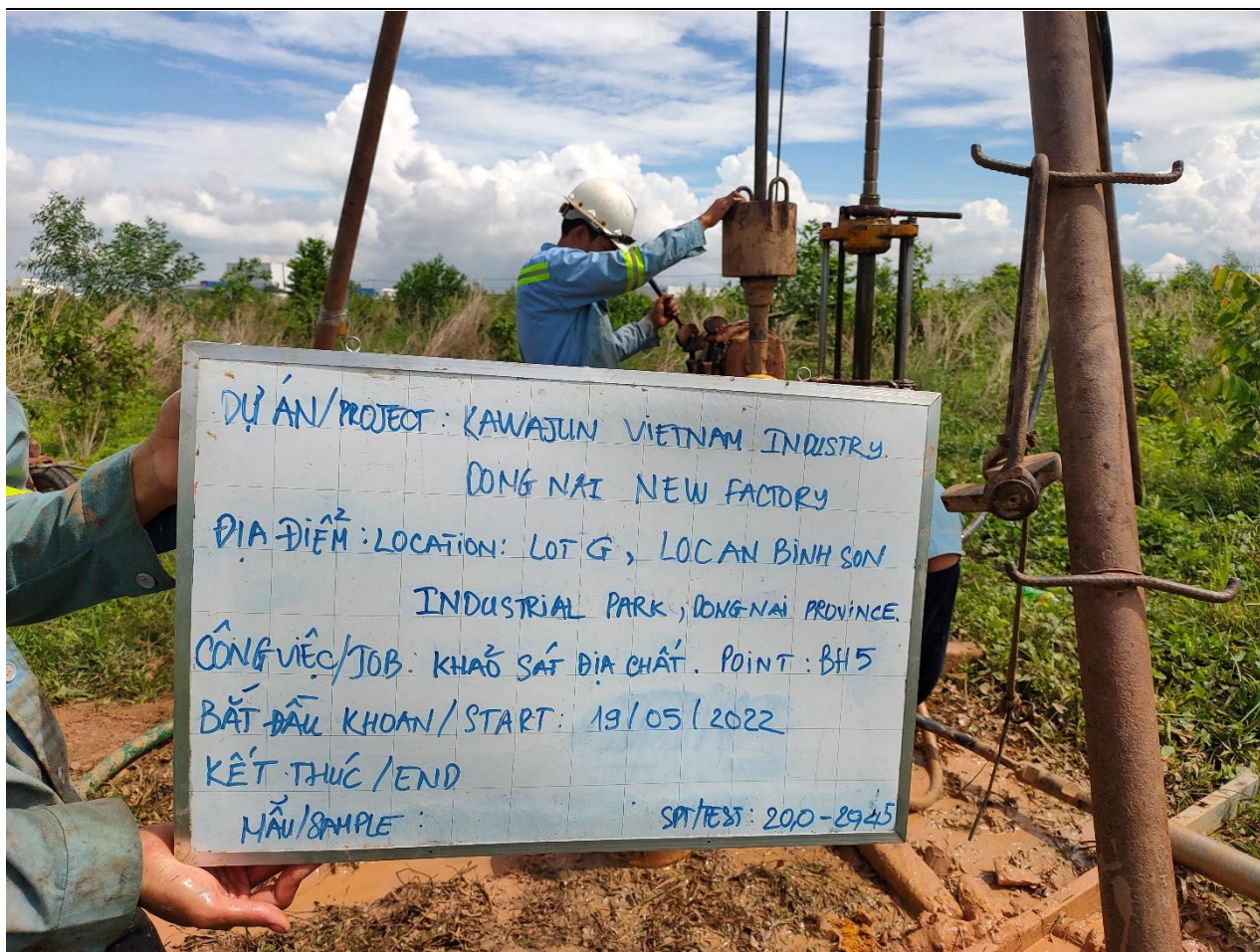
Hình 5: Công tác thí nghiệm SPT/ Fig. 5: SPT test at site
