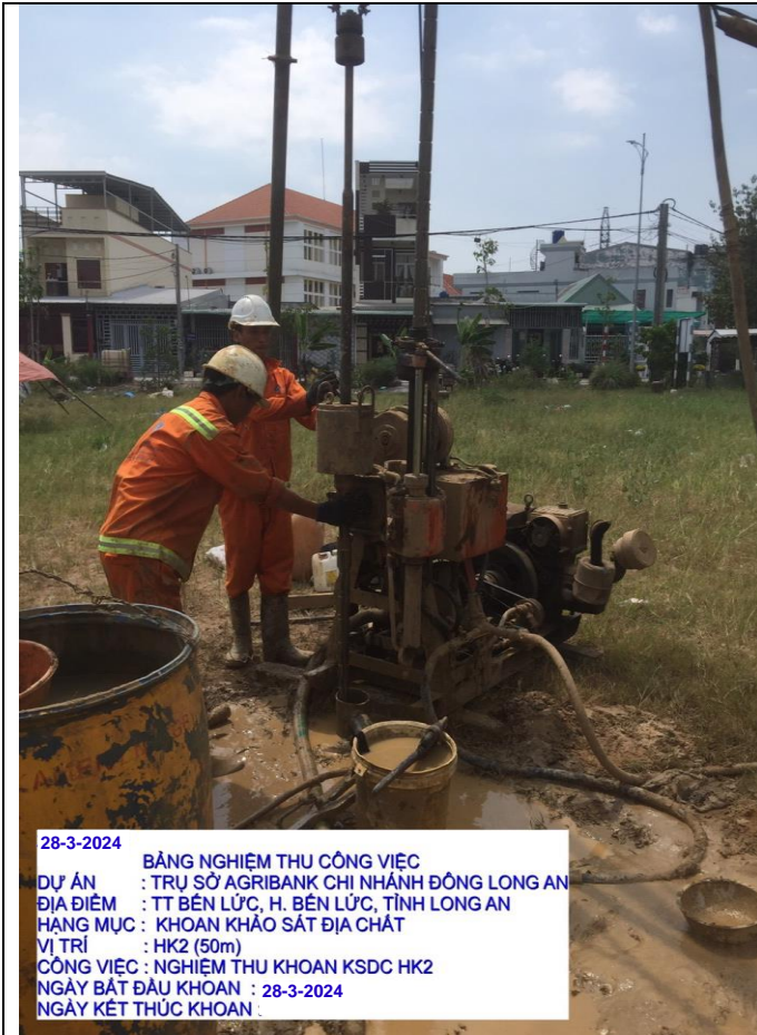
28-3-2024 BẢNG NGHIỆM THU CÔNG VIỆC DỰ ÁN : TRỤ SỞ AGRIBANK CHI NHÁNH ĐÔNG LONG AN ĐỊA ĐIỂM : TT BẾN LỨC, H. BẾN LỨC, TỈNH LONG AN HẠNG MỤC : KHOAN KHẢO SÁT ĐỊA CHẤT VỊ TRÍ : HK2 (50m) CÔNG VIỆC : NGHIỆM THU KHOAN KSDC HK2 NGÀY BẮT ĐẦU KHOAN : 28-3-2024 NGÀY KẾT THÚC KHOAN :
