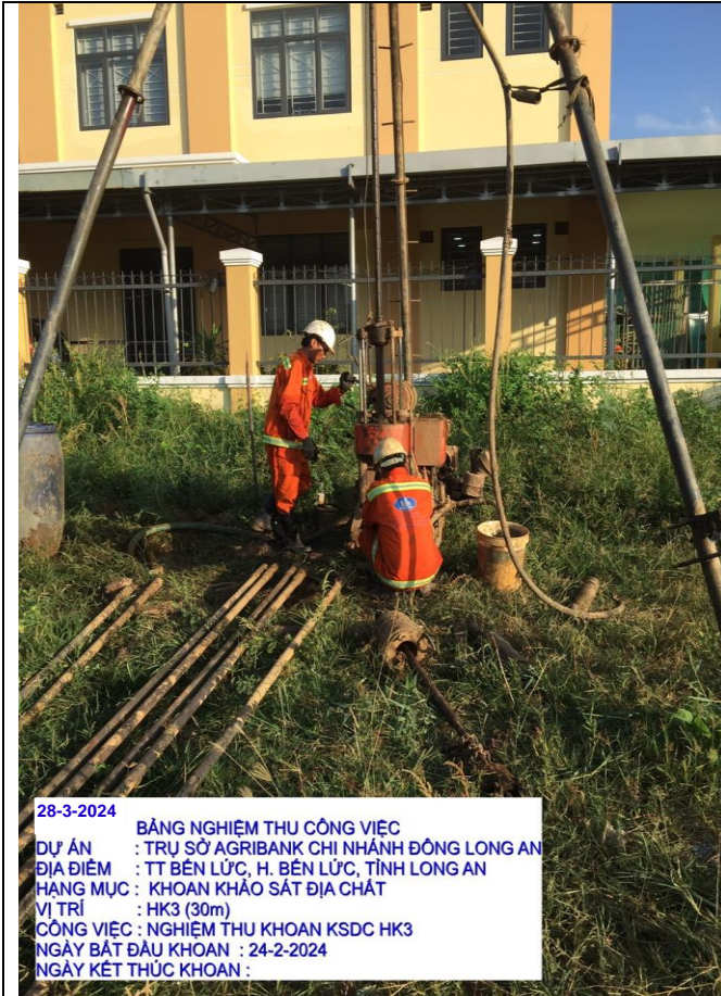
28-3-2024 BẢNG NGHIỆM THU CÔNG VIỆC DỰ ÁN : TRỤ SỞ AGRIBANK CHI NHÁNH ĐÔNG LONG AN ĐỊA ĐIỂM : TT BẾN LỨC, H. BẾN LỨC, TỈNH LONG AN HẠNG MỤC : KHOAN KHẢO SÁT ĐỊA CHẤT VỊ TRÍ : HK3 (30m) CÔNG VIỆC : NGHIỆM THU KHOAN KSDC HK3 NGÀY BẮT ĐẦU KHOAN : 28-3-2024 NGÀY KẾT THÚC KHOAN :
