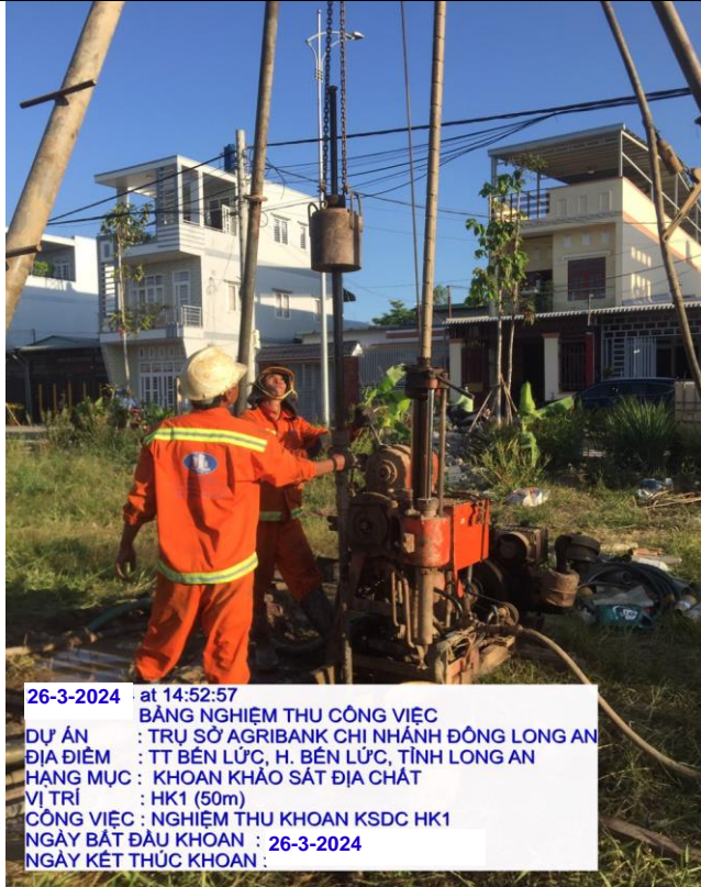
26-3-2024 BẢNG NGHIỆM THU CÔNG VIỆC DỰ ÁN : TRỤ SỞ AGRIBANK CHI NHÁNH ĐÔNG LONG AN ĐỊA ĐIỂM : TT BẾN LỨC, H. BẾN LỨC, TỈNH LONG AN HẠNG MỤC : KHOAN KHẢO SÁT ĐỊA CHẤT VỊ TRÍ : HK1 (50m) CÔNG VIỆC : NGHIỆM THU KHOAN KSDC HK1 NGÀY BẮT ĐẦU KHOAN : 26-3-2024 NGÀY KẾT THÚC KHOAN :
