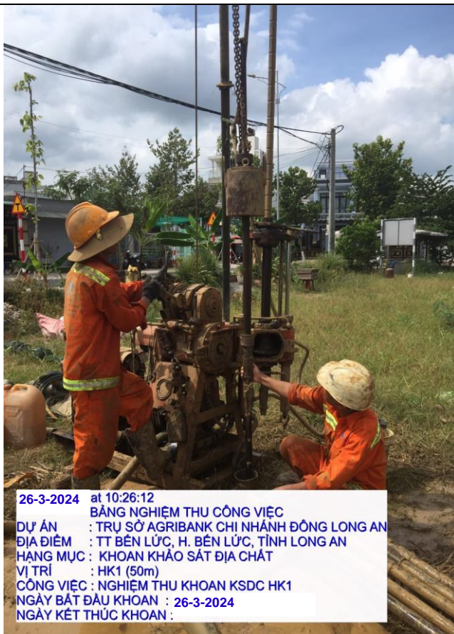
26-3-2024 at 10:13:13 BẢNG NGHIỆM THU CÔNG VIỆC DỰ ÁN : TRỤ SỞ AGRIBANK CHI NHÁNH ĐÔNG LONG AN ĐỊA ĐIỂM : TT BẾN LỨC, H. BẾN LỨC, TỈNH LONG AN HẠNG MỤC : KHOAN KHẢO SÁT ĐỊA CHẤT VỊ TRÍ : HK1 (50m) CÔNG VIỆC : NGHIỆM THU KHOAN KSDC HK1 NGÀY BẮT ĐẦU KHOAN : 26-3-2024 NGÀY KẾT THÚC KHOAN :
